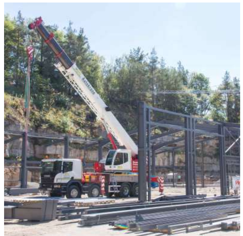
Die alte Halle wurde abgerissen und mit einer eigenen Abbruchparty mit Musik und Spaß verabschiedet. Die Bauarbeiten für den neuen Bauhof haben begonnen. Bild: Helmut Groß
