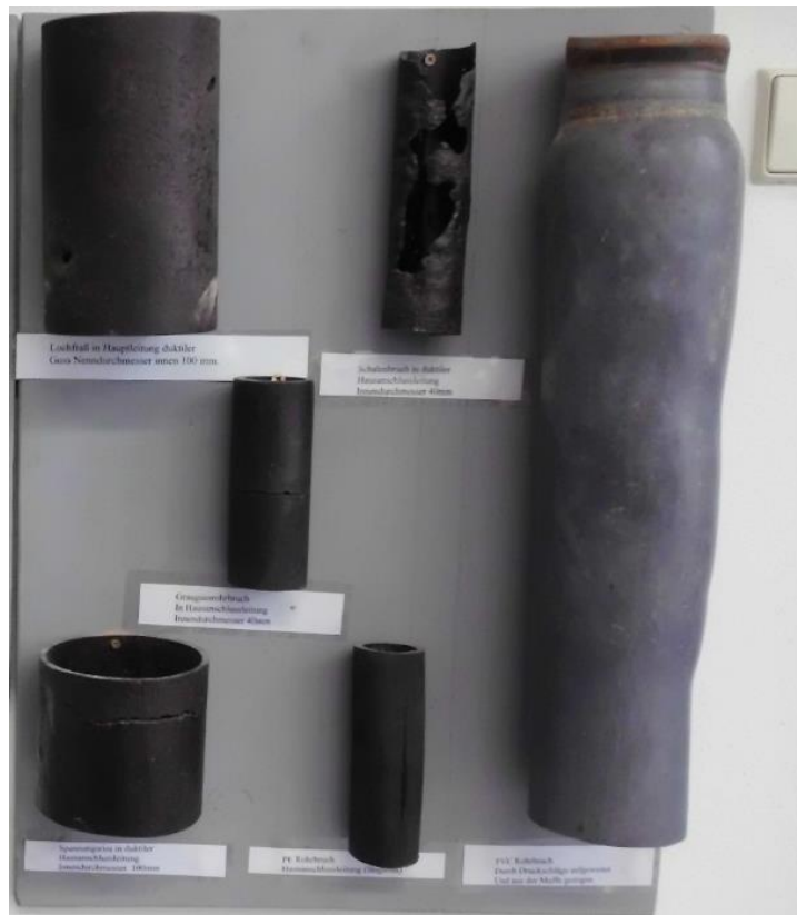
Beispiel für ein verformtes Kunststoffrohr; Beispiele für Wasserleitungen mit Lochfrass
