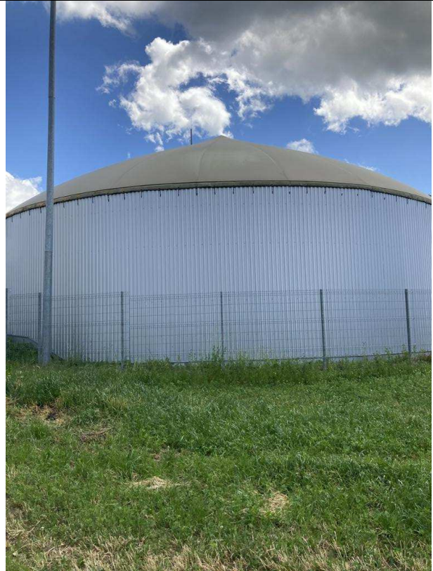
Abb. 10: Gärrestlager; Blick von Süden
