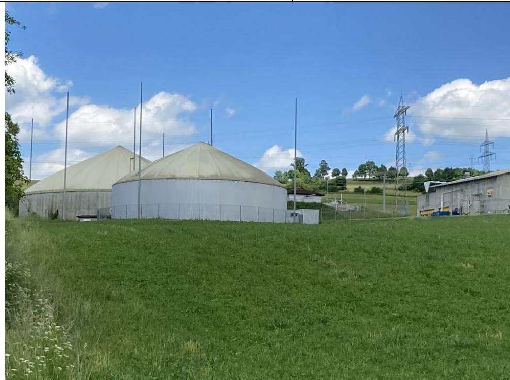
Abb. 11: Gärrestlager (Vordergrund) und Fermenter II (Hintergrund) Blick von Südost
