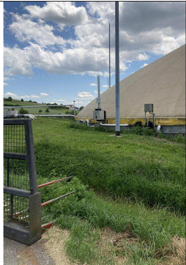
Abb. 5: Fermenter II; Erddeckung im nördlichen Bereich auf dem Anlagenplateau; (Blick nach Osten)
