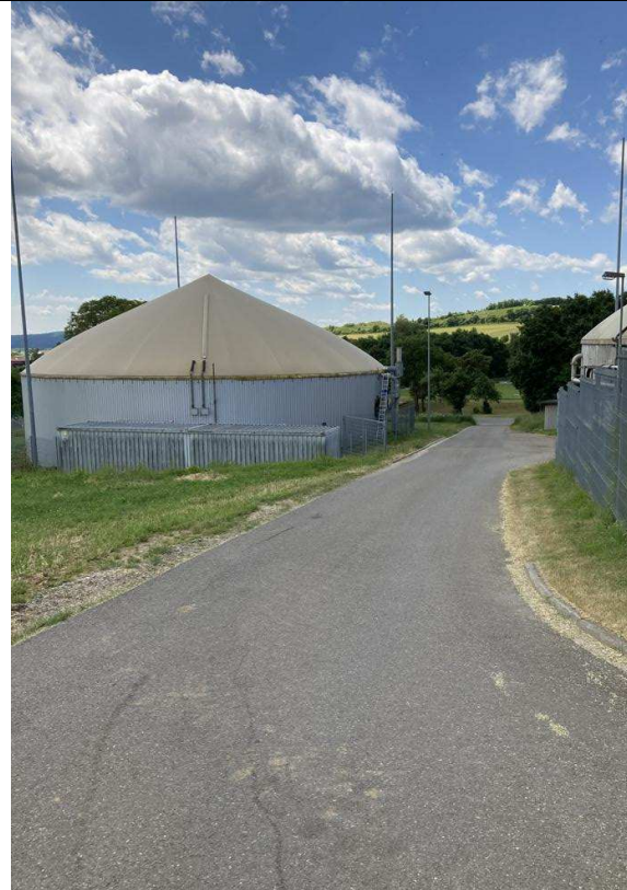
Abb. 9: Gärrestlager; Blick von Norden
