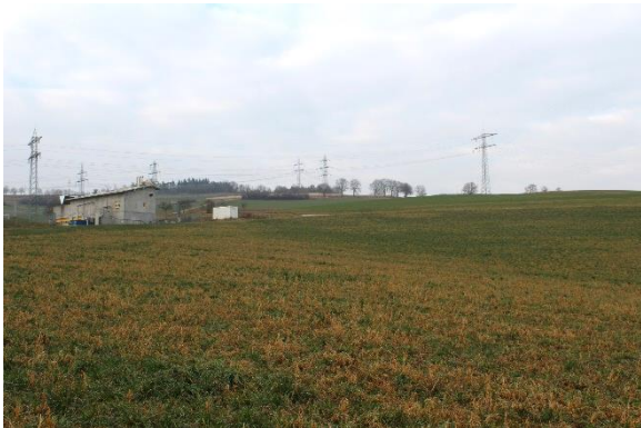
Blick vom Südwesten des Plangebietes direkt nach Norden. Zu sehen ist ein Teil des bestehenden Naturkraftwerks sowie die weiter nördlich verlaufenden Hochspannungsleitungen.
