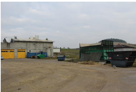
Blick innerhalb der bestehenden Anlage nach Osten. Direkt hinter dem Container ist der bewaldete Gipfel des Wannbergs zu erkennen.
