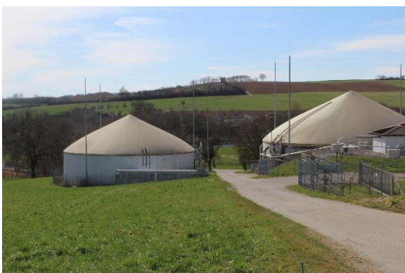
Blick von Nordosten auf die bestehenden Fermenter mit Tragluftdach.
