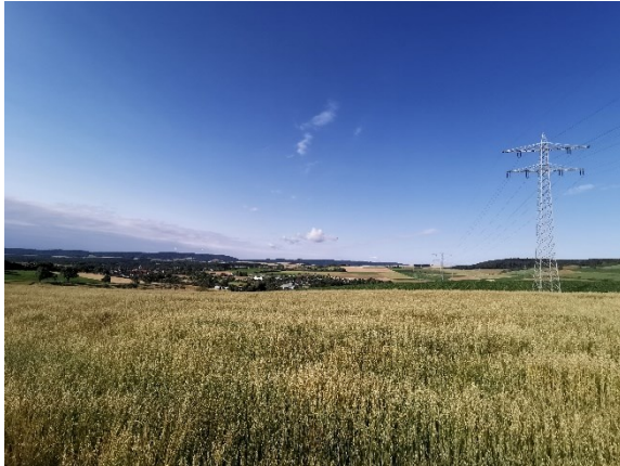
Blick von der Kreisstraße nach Westen. Rechts im Bild die 110kV-Hochspannungsleitung, die nicht mit Modulen unterbaut wird.
