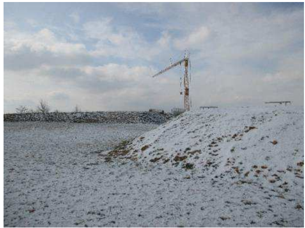
Die östlich angrenzende Fläche (hinterer Bildbereich) wird bereits bebaut. Im Plangebiet ist ein Erdlager der angrenzenden Baustelle vorhanden
