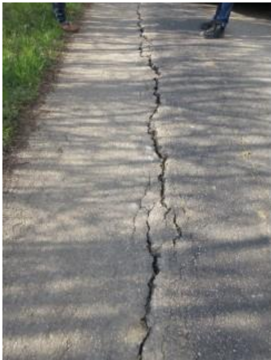
Beuren, Waldstraße Richtung Weil
